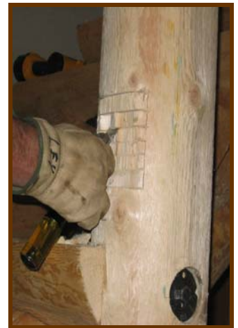
Remove to kerf cuts
